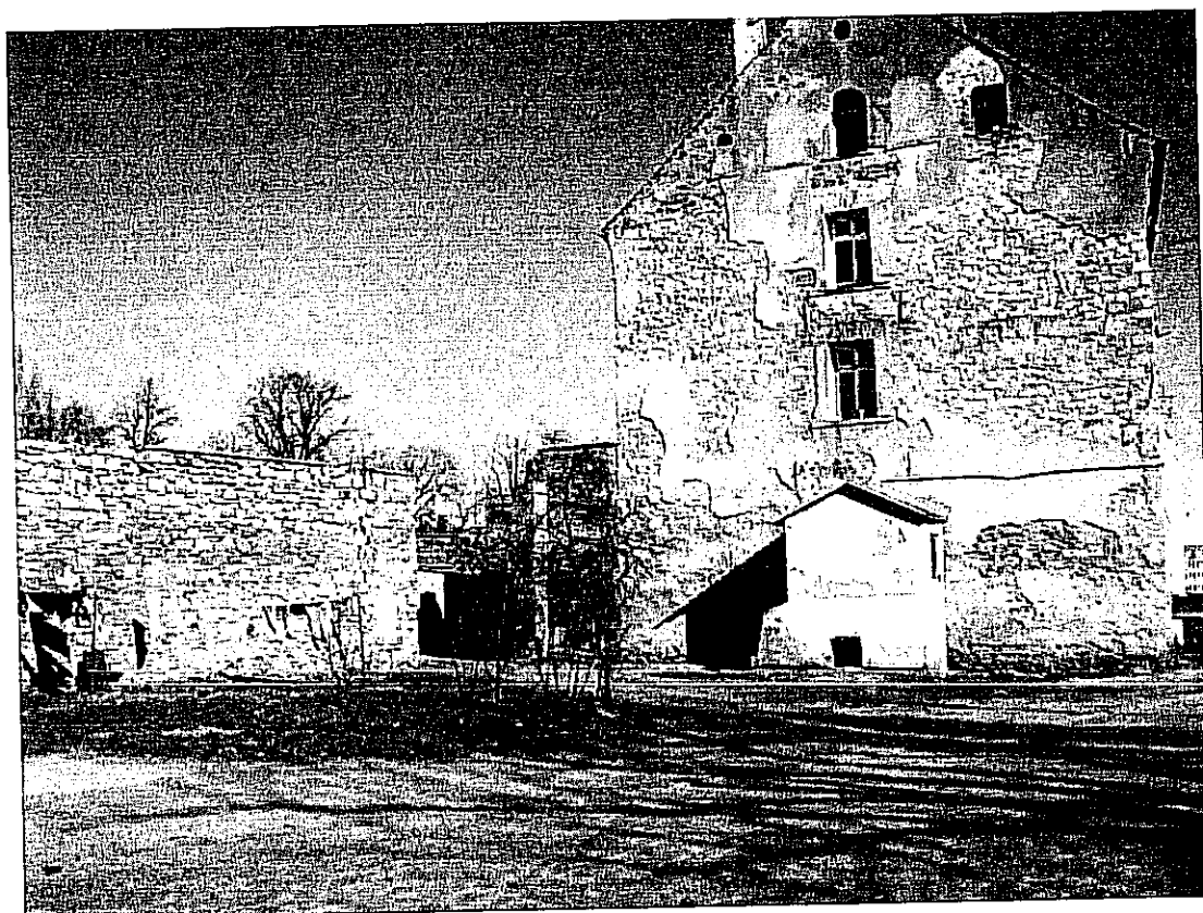
Fot. 5. Budynek przy ulicy Pocztowej – widok od strony ulicy.
